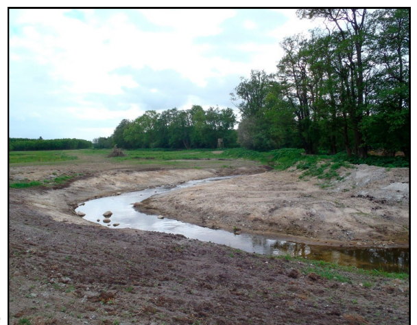
Reetablering af vandløb med naturlig slyngning
